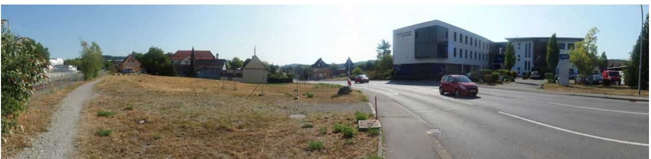
Abb. 5: Überblick über den westlichen Teil des Plangebietes im Bereich des Bahnübergangs mit Blick in Richtung Osten.
