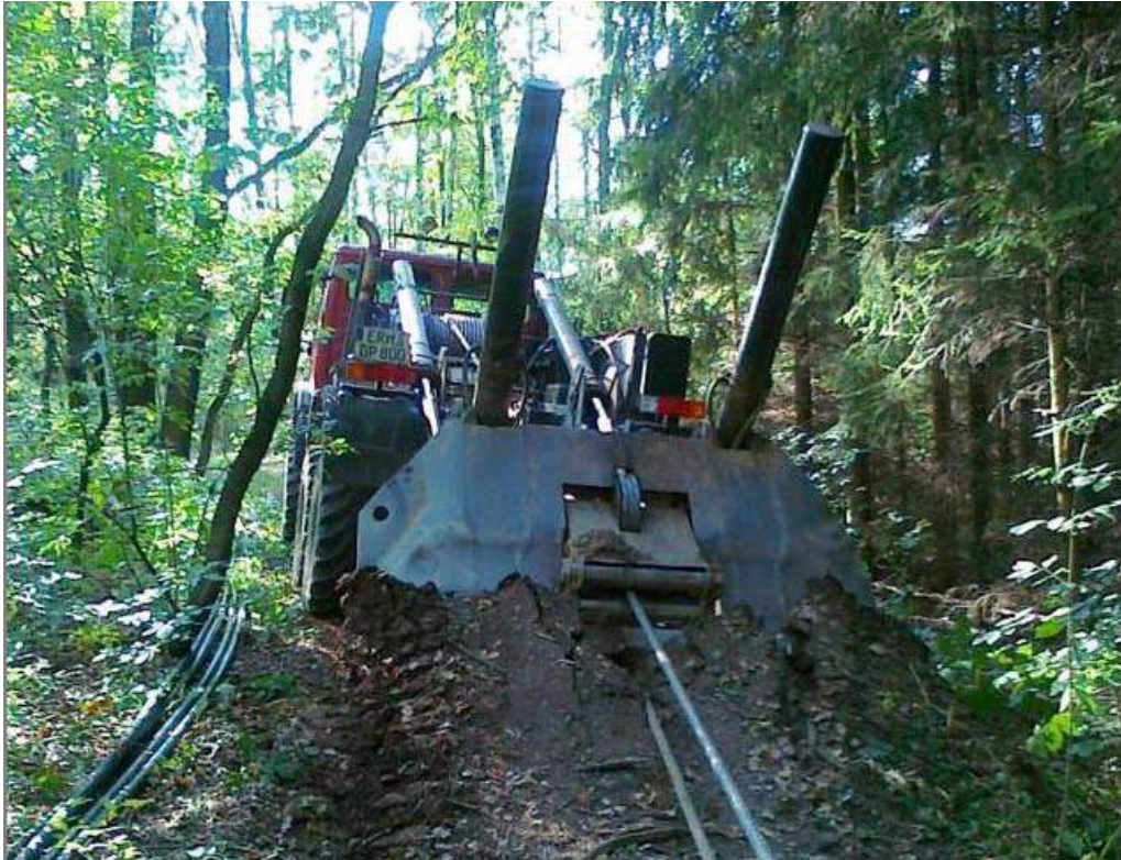
Abb. 7 Leitungsbau im Wald
