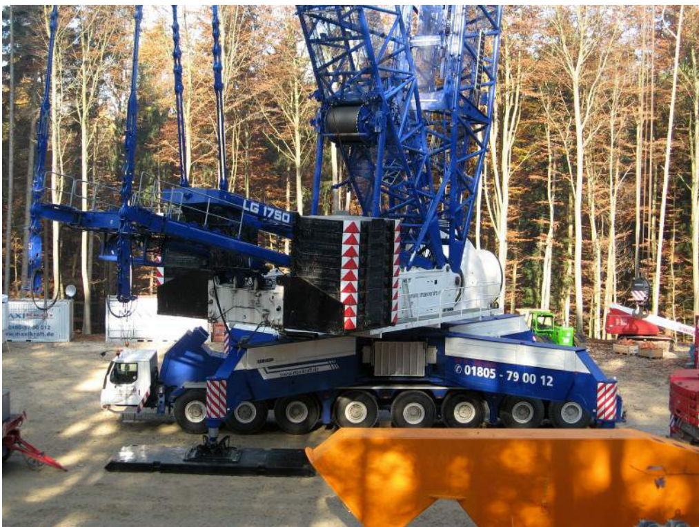
Abb. 5 Kran zum Aufbau einer WEA im Wald
