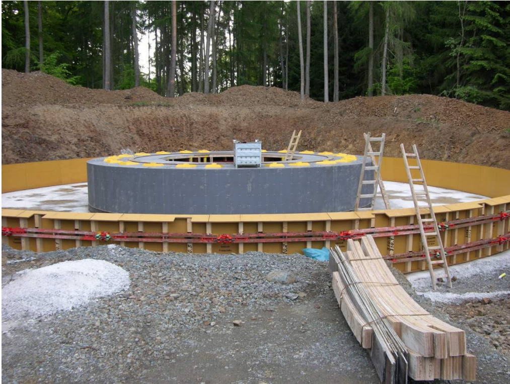
Abb. 4 Fundament einer WEA
