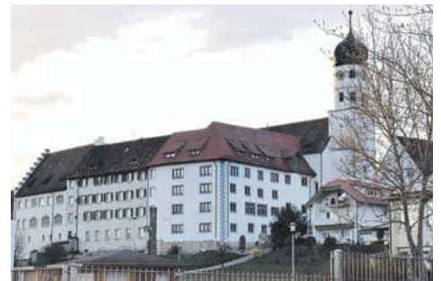
Die künftige Nutzung des Prosteigebäudes vom Chorherrenstift ist geklärt. Im Erdgeschoss und im ersten Obergeschoss entsteht ein Gastronomiebetrieb mit Gästezimmern im zweiten und dritten Obergeschoss. Das Dachgeschoss wird zu einem Veranstaltungssaal ausgebaut. sub-Bild: hz
